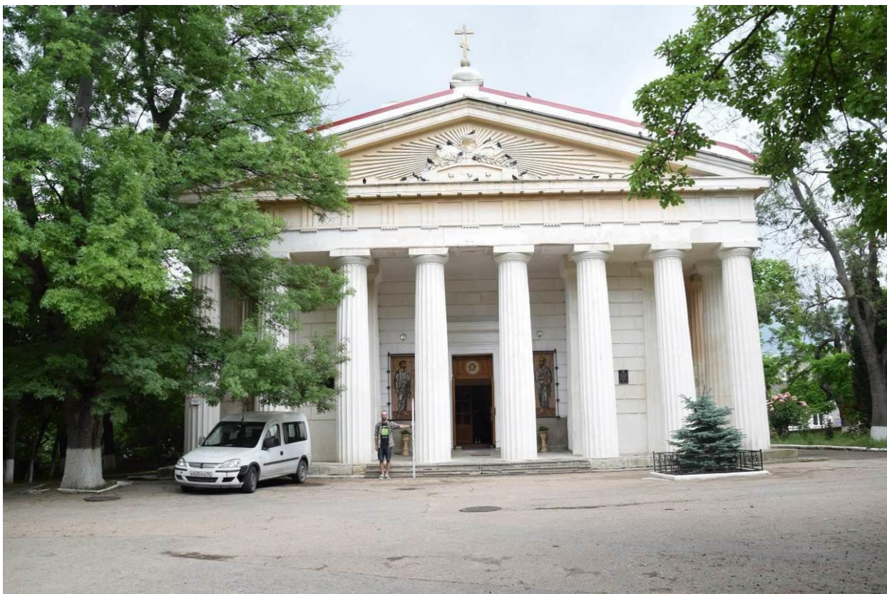
Рис. 25. Город Севастополь. Капитальный ремонт сквера у собора Петра и Павла. Территория исследований. Восточная часть. Храм святых апостолов Петра и Павла. Вид с запада.
