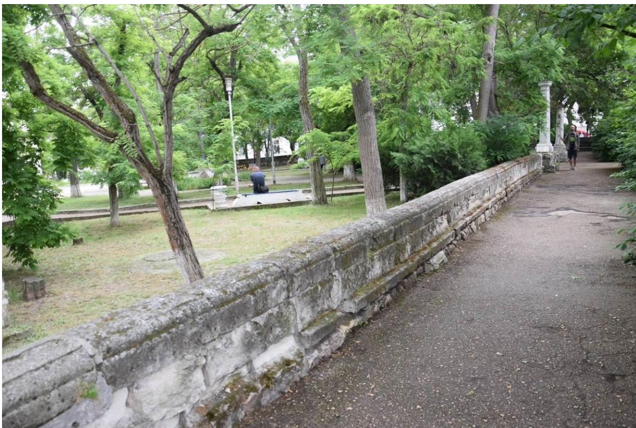
Рис. 14. Город Севастополь. Капитальный ремонт сквера у собора Петра и Павла. Территория исследований. Западная часть. Вид с северо-запада.
