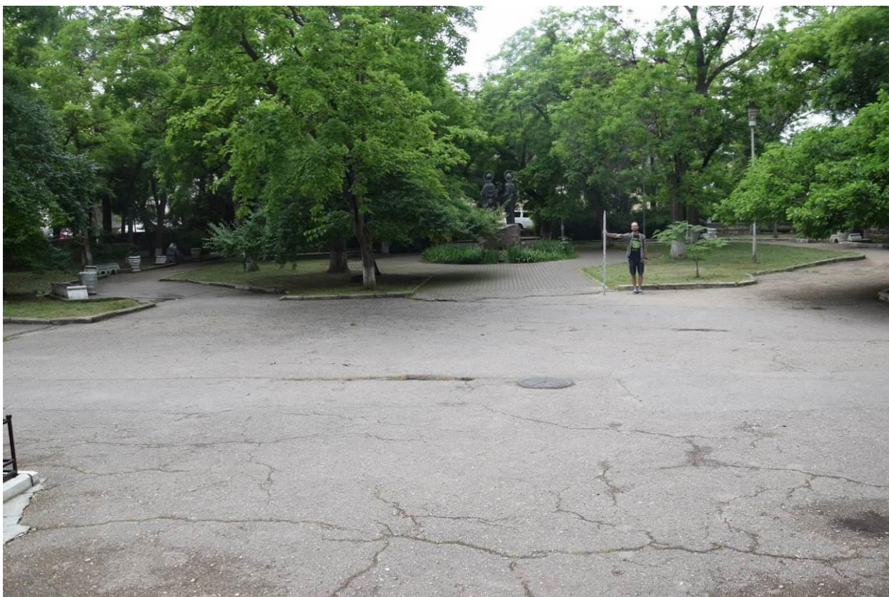
Рис. 20. Город Севастополь. Капитальный ремонт сквера у собора Петра и Павла. Территория исследований. Западная часть. Вид с востока.
