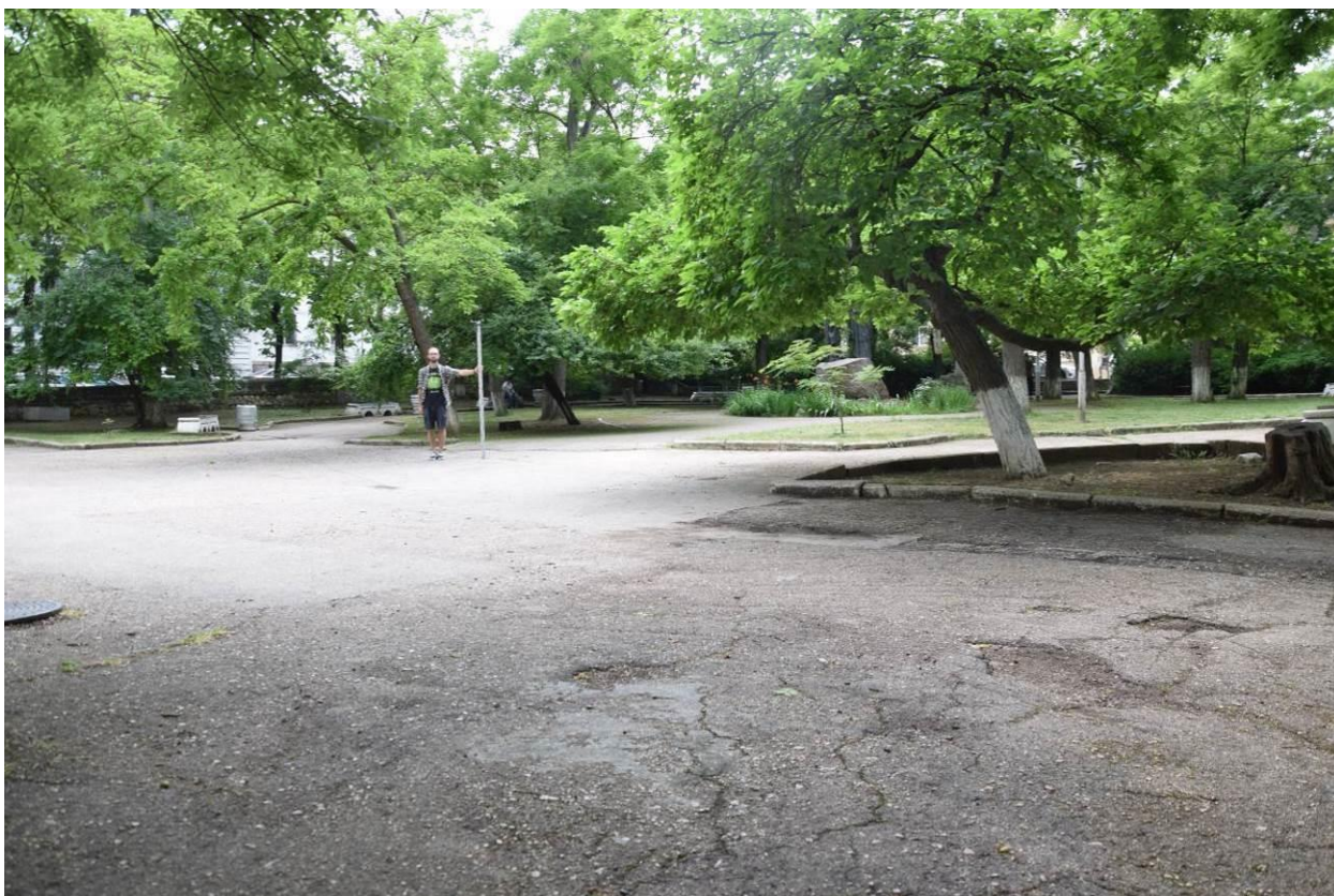
Рис. 22. Город Севастополь. Капитальный ремонт сквера у собора Петра и Павла. Территория исследований. Западная часть. Вид с северо-востока.
