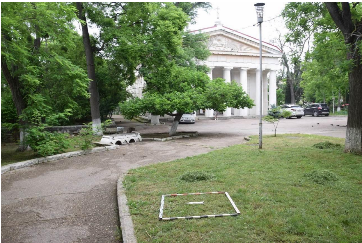
Рис. 41. Город Севастополь. Капитальный ремонт сквера у собора Петра и Павла. Территория исследований. Шурф 1 до начала работ. Вид с запада.
