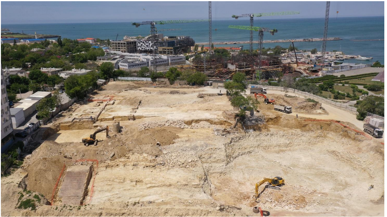
Рис. 5. Вид сверху на внутрикомплексный объект «Фундамент храма Св. Иоанна Воина с остатками лестницы и мостовой» до проведения работ по консервации элементов храма-апсиды и северной лестницы
