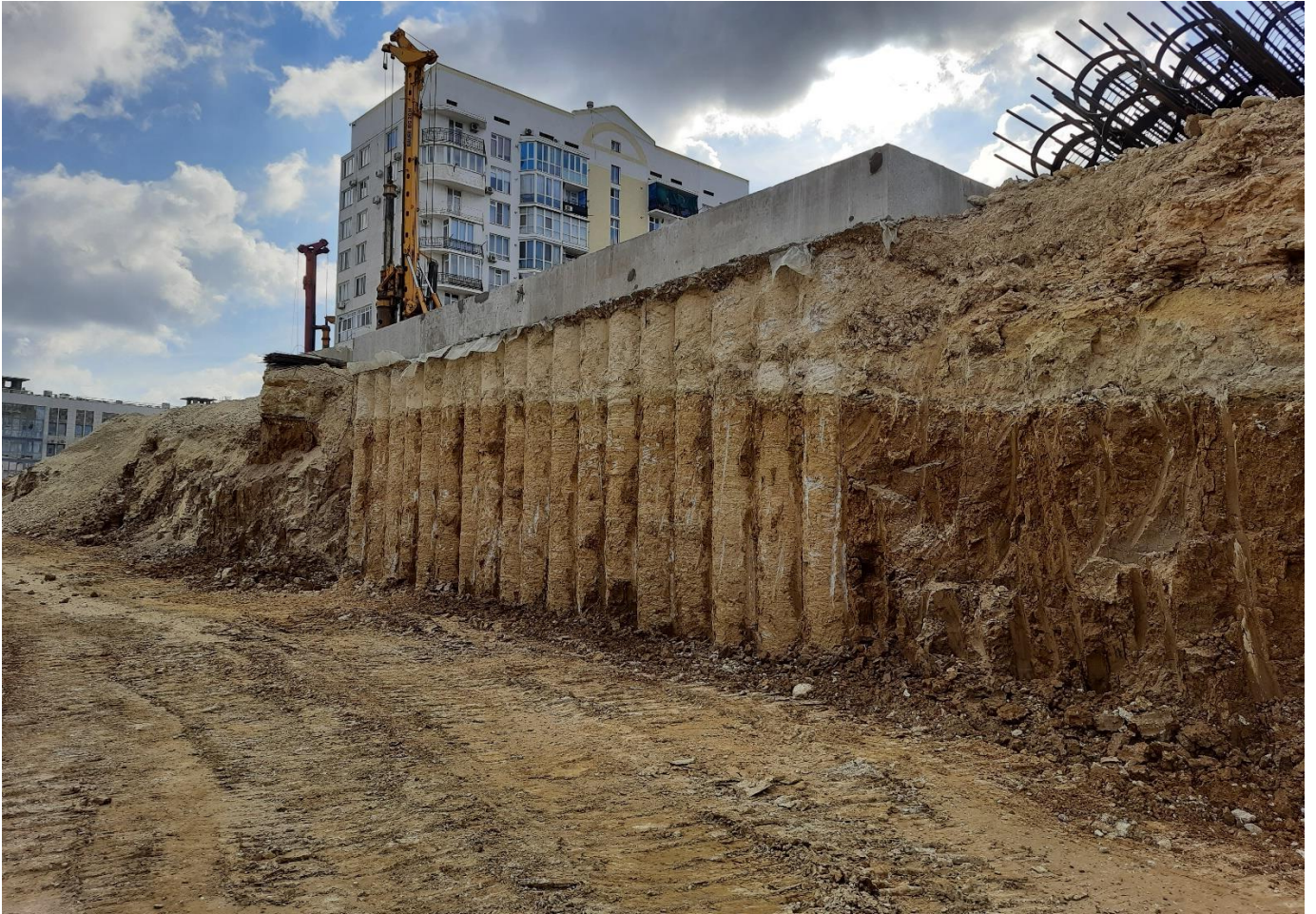
Рис. 8. Вид на сохраняемый элемент храма – апсиду. Выполнена свайная подпорная стена «стакана» (технология «стена в грунте») после выемки грунта до проектируемого уровня 27.60-28.24 м одной из площадок музейного комплекса. Ноябрь 2022.
