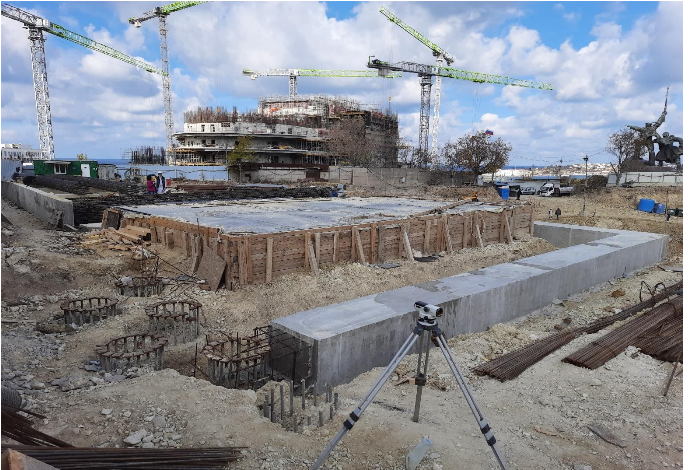
Рис. 7. Вид на сохраняемый элемент храма – апсиду, с завершенными работами 1-го этапа (консервация) и выполненной частью 2-го этапа по устройству свай (технология «стена в грунте»). С трех сторон «стакана» выполнено устройство обвязочных балок. Наблюдается участок «мертвой зоны» для буровой установки – это размер деревянного ограждения апсиды со стороны границы строительной площадки музейного комплекса с существующей жилой застройкой. Ноябрь 2022.
