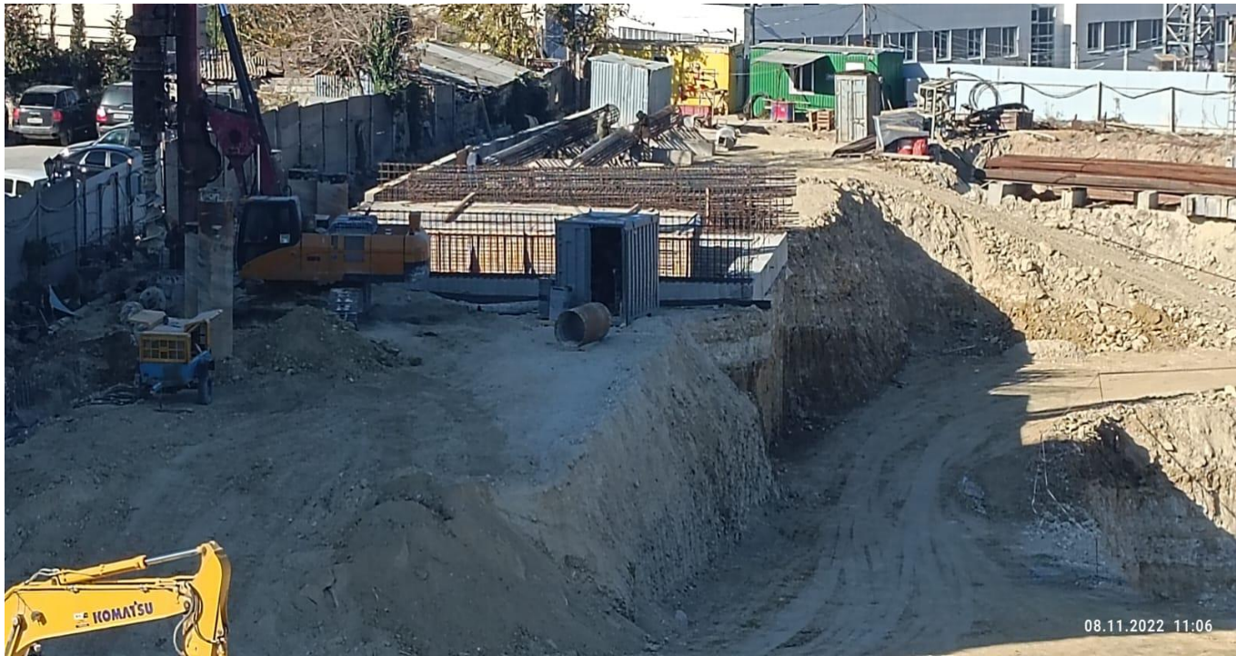
Рис. 6. Вид на сохраняемый элемент храма – апсиду, с завершёнными работами 1-го этапа (консервация) и выполненной частью 2-го этапа по устройству свай (технология «стена в грунте»)
